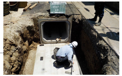
排水整備工事の様子
